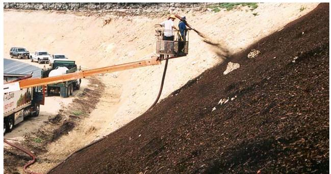
Aplicación de una manta de compost sembrado en una pendiente rocosa de 1:1
