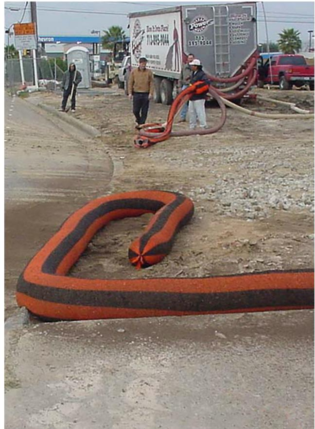
**Manga filtrante de compost utilizada como compuerta para detener flujos erosivos.**
